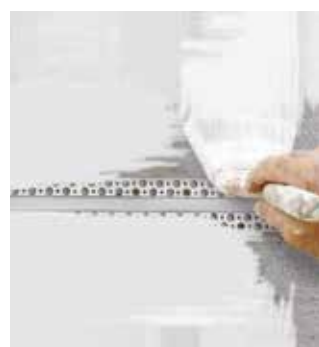
Assurez-vous que le cache ne soit pas recouvert lors du plâtrage.
