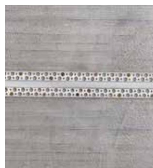
Installez le profil en aluminium dans la fente et fixez-le avec des vis.
