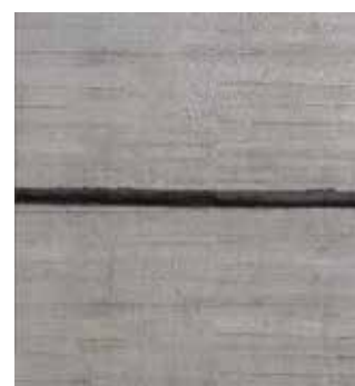
Selon le dessin de construction, pratiquez une entaille dans le placo.
